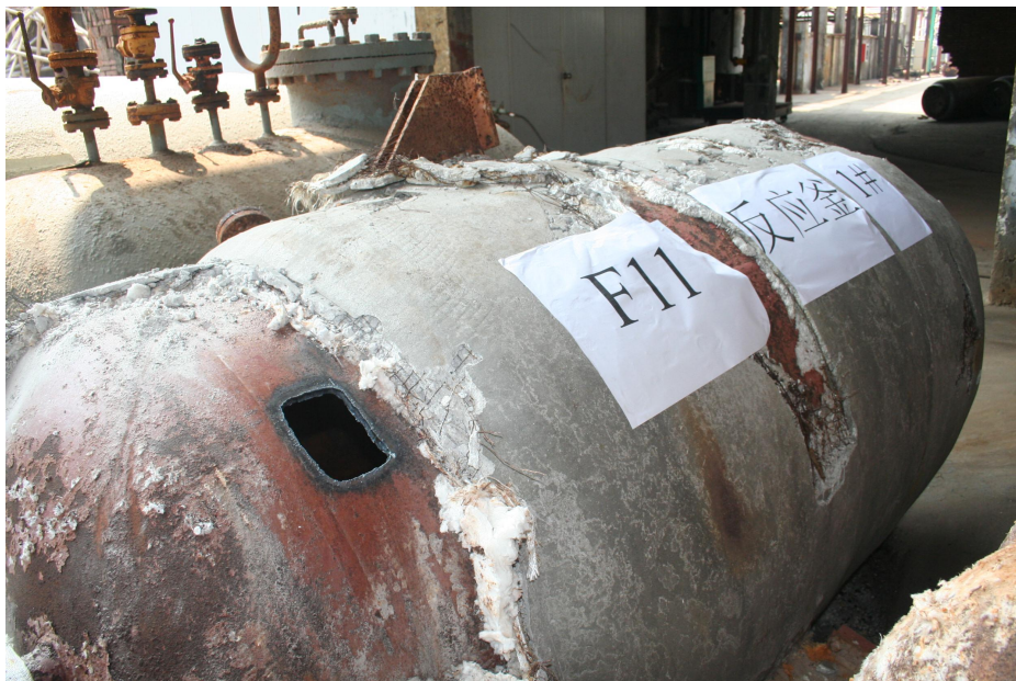
图 6 常熟 3F CFC-11 装置的拆除
