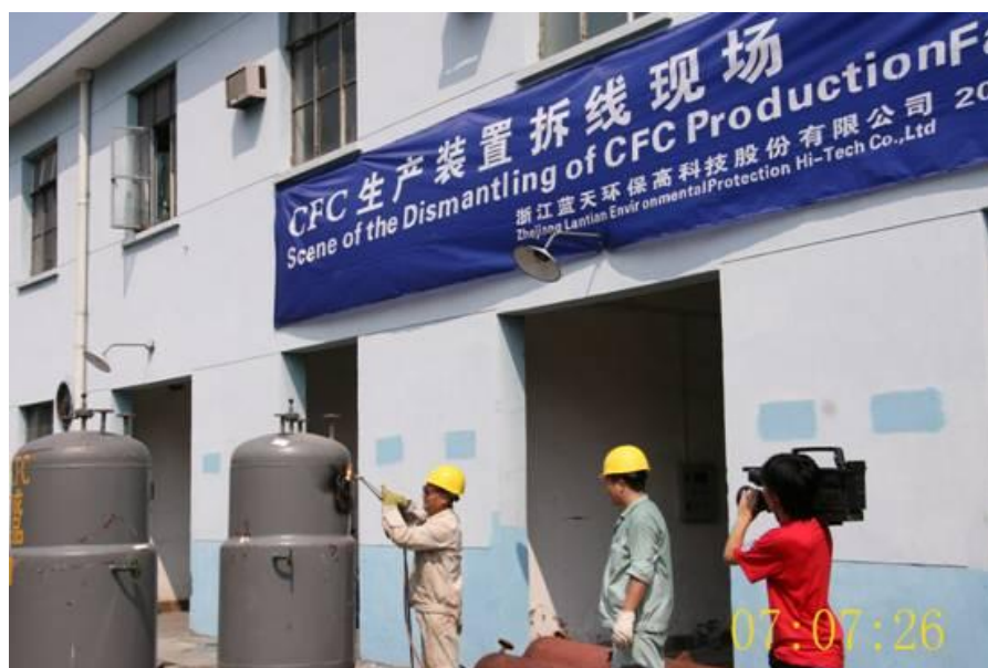
图 8 蓝天环保 CFC 生产装置拆除现场
