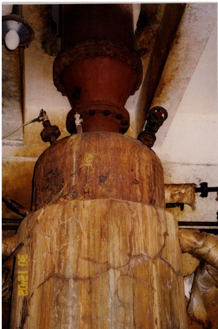
图 2 拆除前的 CFC-12 氟化反应釜（临海利民）
