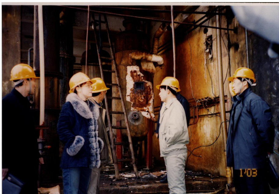
图 3 拆除后的 CFC-12 氟化反应釜（临海利民）
