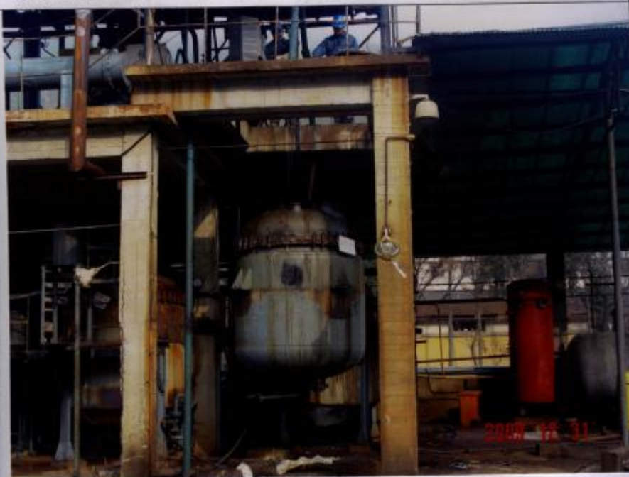
照片内容：TCA 生产装置 2#反应釜切割捣毁后照片
