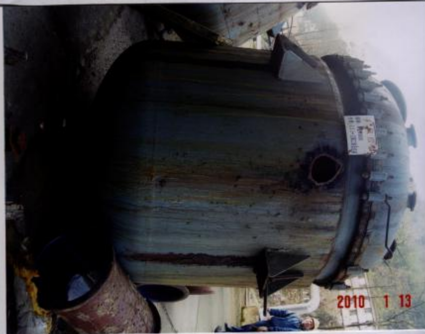
照片内容：TCA 生产装置 4#反应釜切割捣毁后照片
