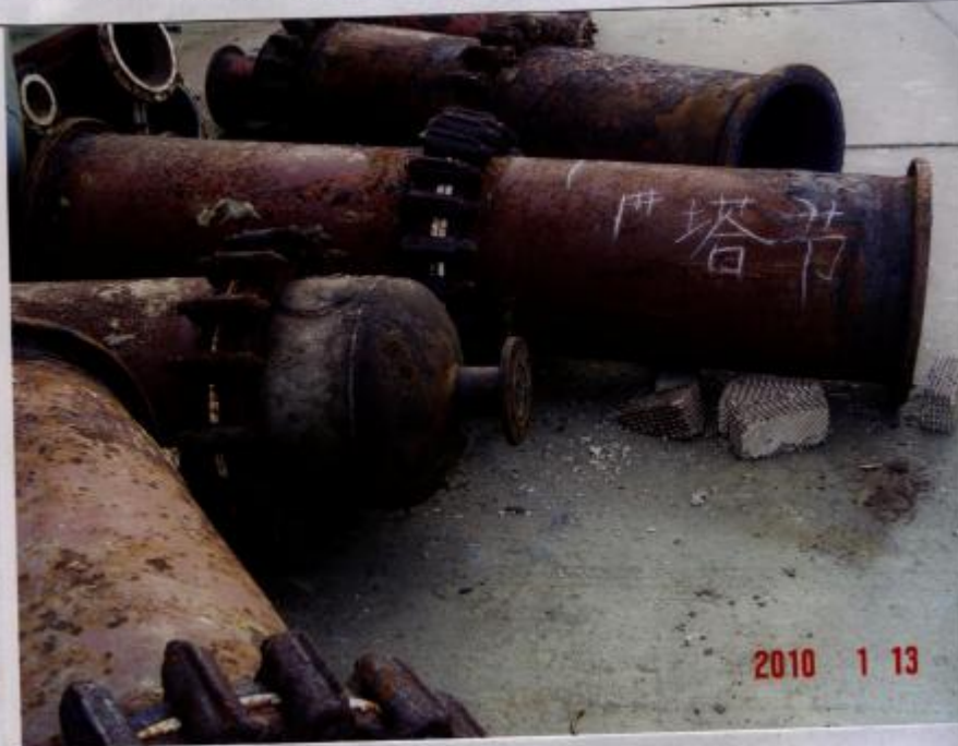
照片内容：TCA 生产装置 2#精馏塔捣毁后照片
