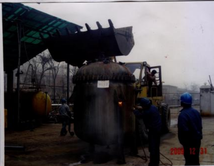
照片内容：TCA 生产装置 1#反应釜切割捣毁中照片
