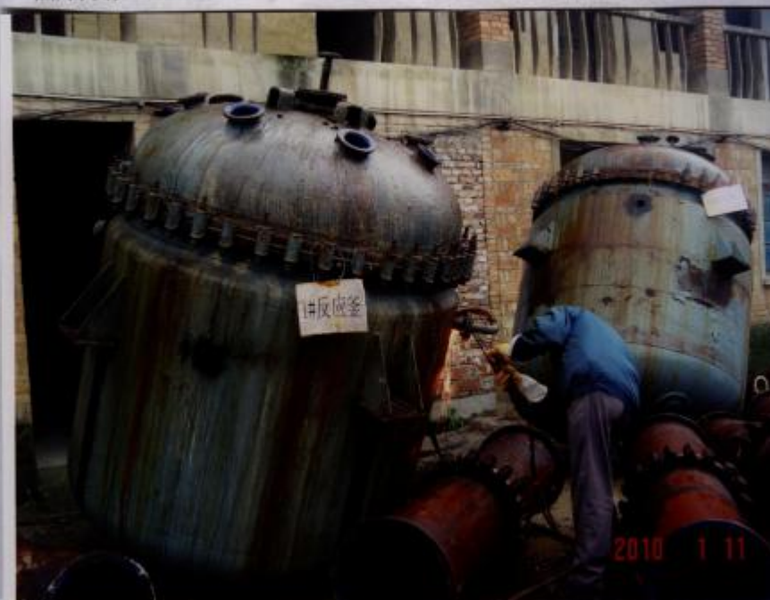
照片内容：TCA 生产装置 1#反应釜切割捣毁中照片
