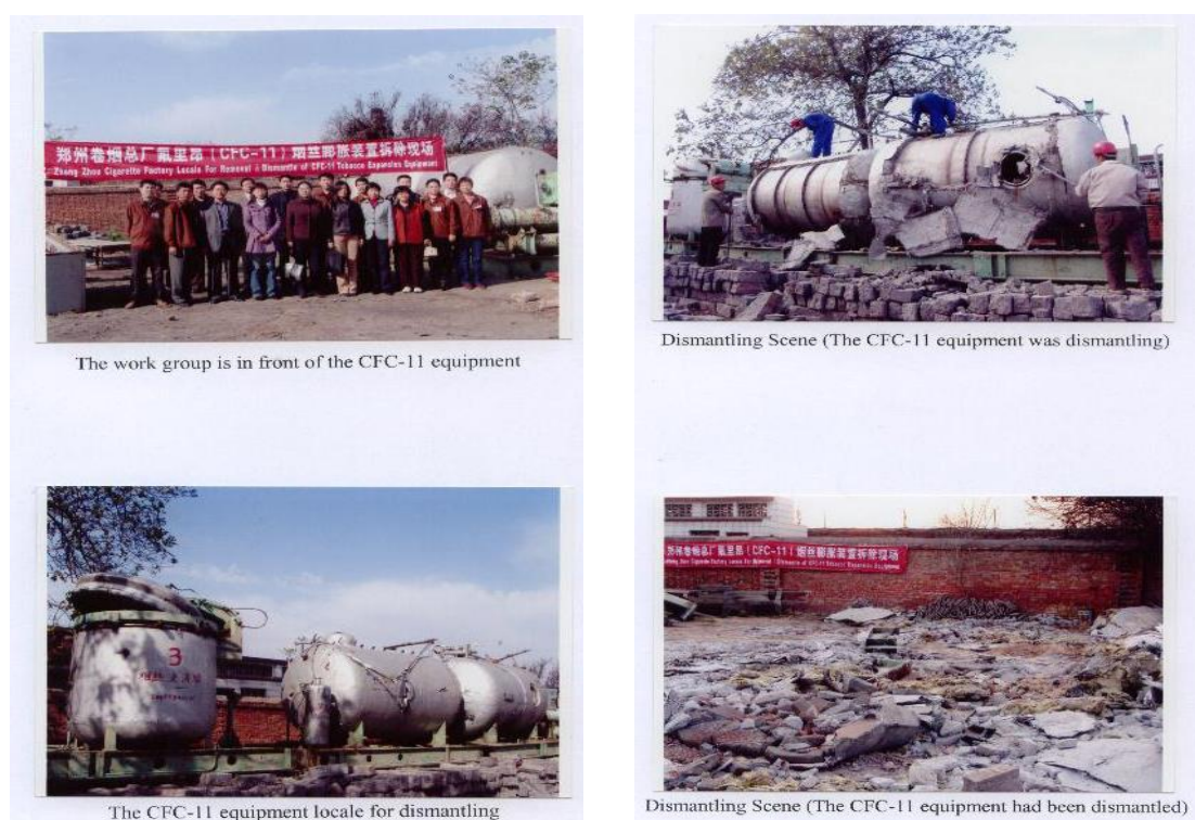
图 4-1 郑州卷烟厂 CFC-11 拆除现场
